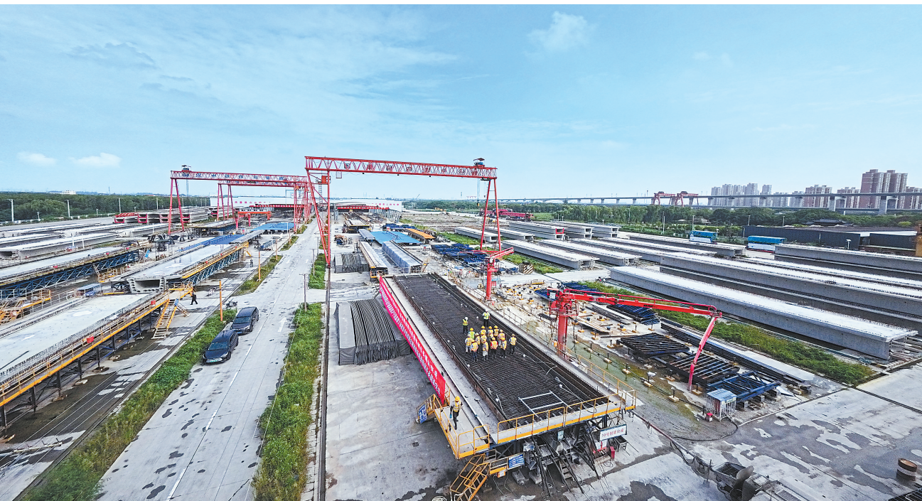
9月22日,在中铁四局宝慧制梁场,一标长32.6米、重达370.7吨的箱梁顺利浇筑完成,标志着该制梁场1668榀箱梁预制任务全部完成,为沪宁合高铁沪宁段及沪苏通铁路二期工程建设全面推进奠定了坚实基础。
