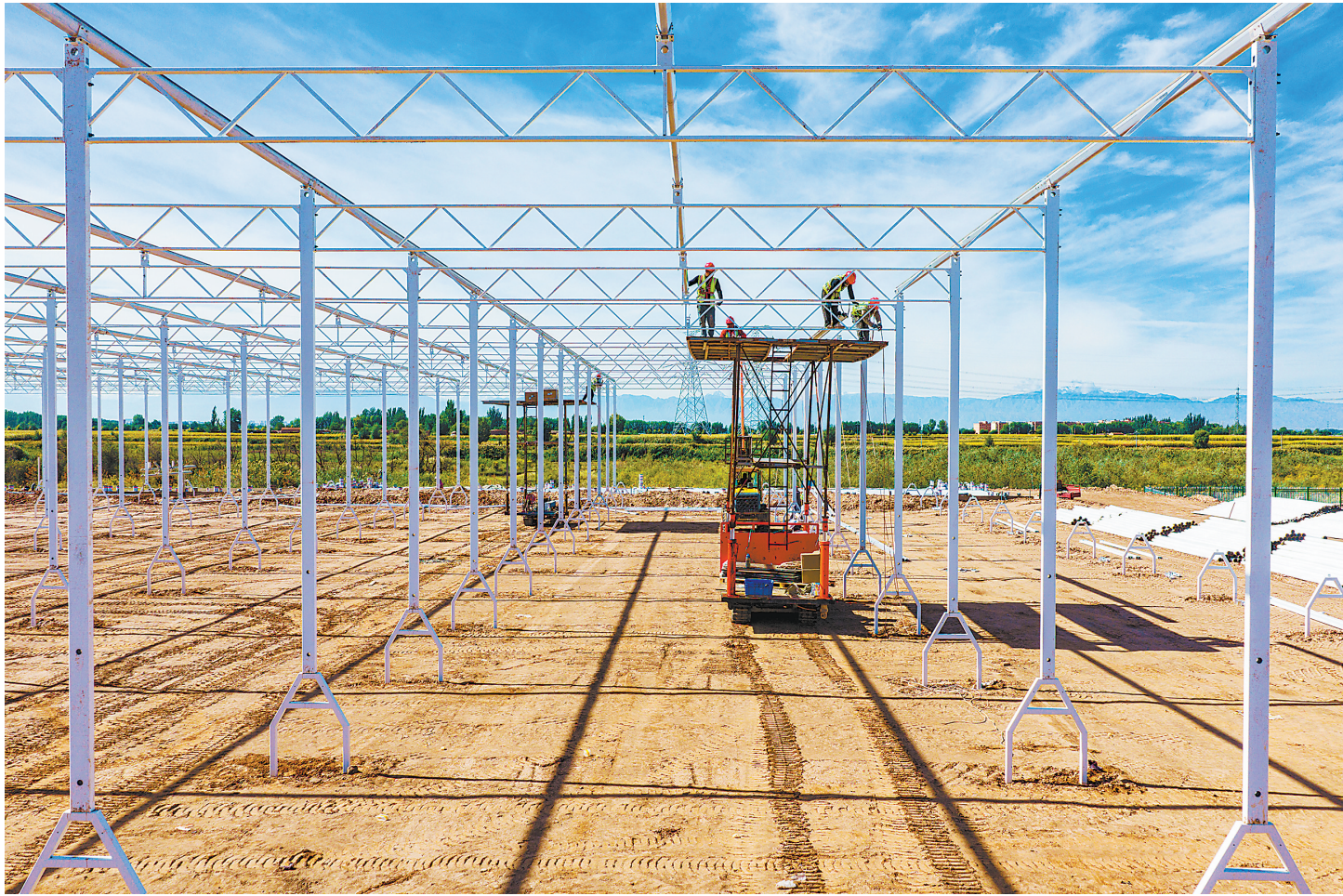
近日,在张掖市甘州区三坝镇三和智能玻璃温室项目建设工地,工人进行安装施工作业。
