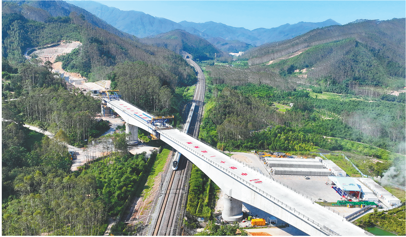
9月18日,动车从完成转体施工的漳汕高铁洋奎村特大桥桥下穿行而过。洋奎村特大桥坐落于福建省漳州市龙海区程溪镇,全长1545米。该转体连续梁全长近280米,顶宽约13米,主跨约130米。 新华社记者 林善传
