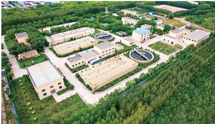
民勤县给排水管理站污水处理厂。侯洪建
