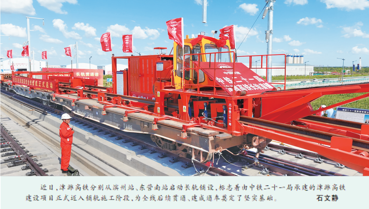
近日,津浦高铁分别从滨州站、东营南站启动长轨铺设,标志着由中铁二十一局承建的津浦高铁建设项目正式迈入铺轨施工阶段,为全线后续贯通、建成通车奠定了坚实基础。 石文静
