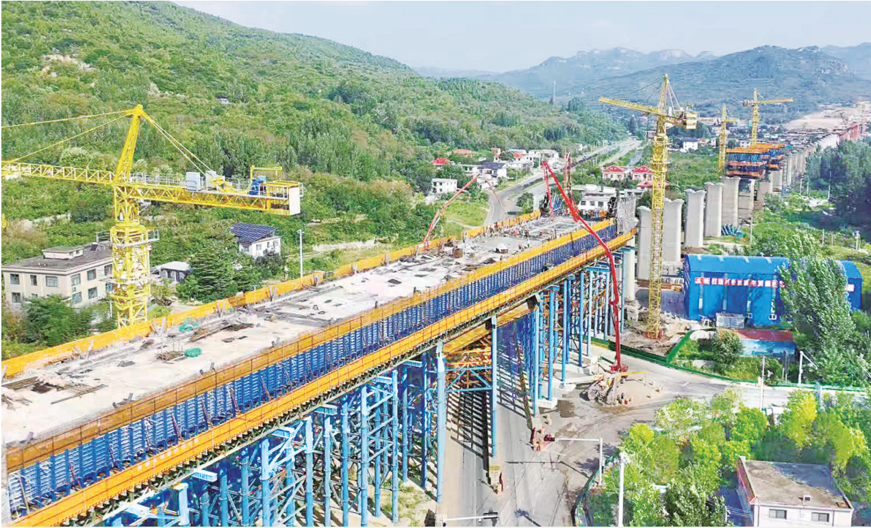
8月25日,由中铁二十一局承建的济东铁路项目南山站特大桥144米钢管混凝土系杆拱梁体施工任务圆满收官。图为项目施工现场。
