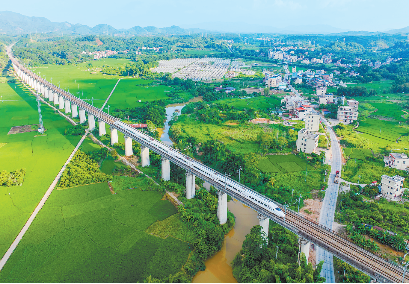
9月7日，在广西梧州市龙圩区大坡镇河步村，动车组列车在田野上飞驰而过。
