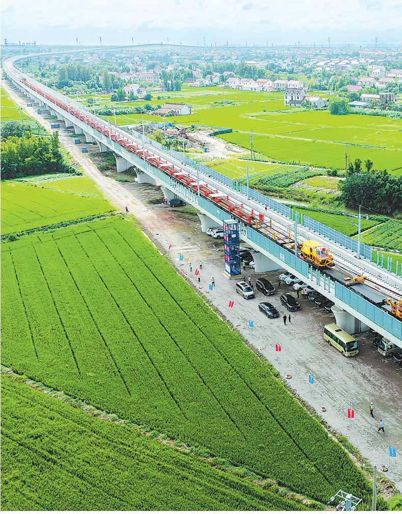
9月3日，在中铁一局江苏南通泰扬特大桥铺轨作业现场，首对500米长钢轨在铺轨机牵引下精准落位，标志着沪渝蓉高铁沪宁段铺轨施工启动，为后续全线铺轨贯通奠定坚实基础。图为当日拍摄的中铁一局江苏南通泰扬特大桥铺轨作业现场。
