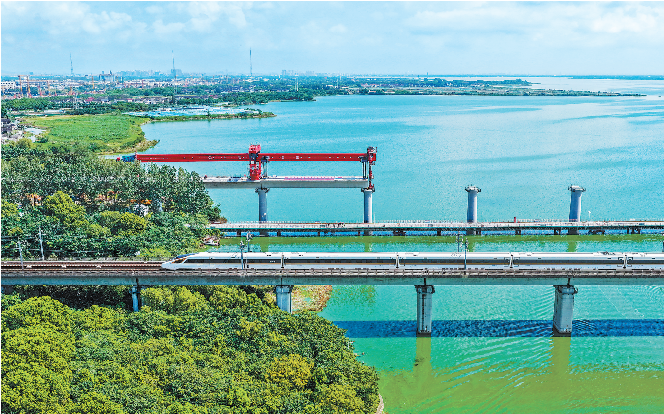
9月1日拍摄的通甬高铁苏虞特大桥跨阳澄湖水域箱梁架设施工现场。当日,新建南通至宁波高速铁路(简称通甬高铁)苏虞特大桥跨阳澄湖水域首榀箱梁架设顺利完成。通甬高铁建成后将完善长三角地区高速铁路网布局,推动长三角高质量一体化发展。 新华社发
