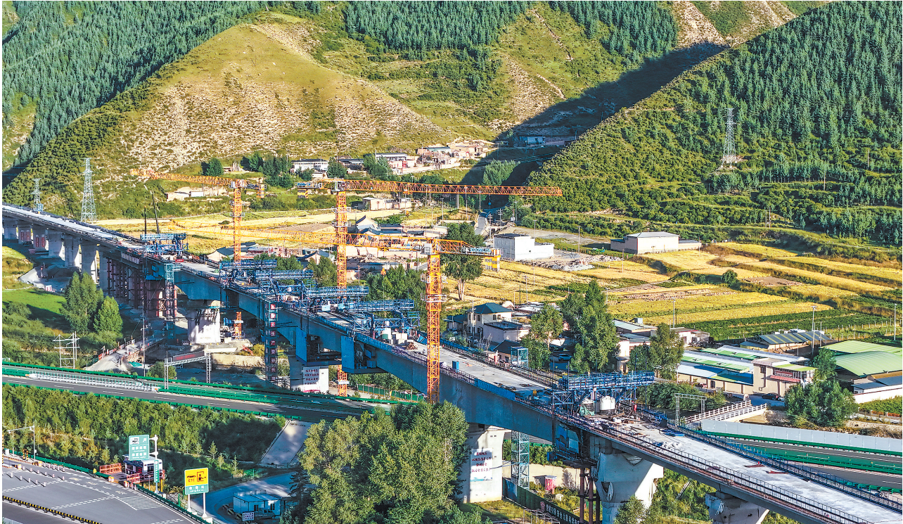
建设中的兰合铁路。 新甘肃·甘肃日报通讯员 徐知遥
