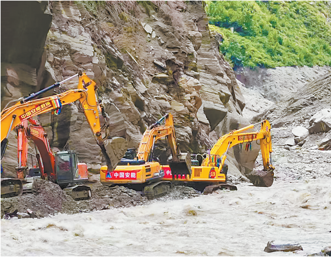
8月29日，应急管理部调派中国安能工程力量持续开展道路抢通作业。新华社记者 旦增尼玛曲珠
