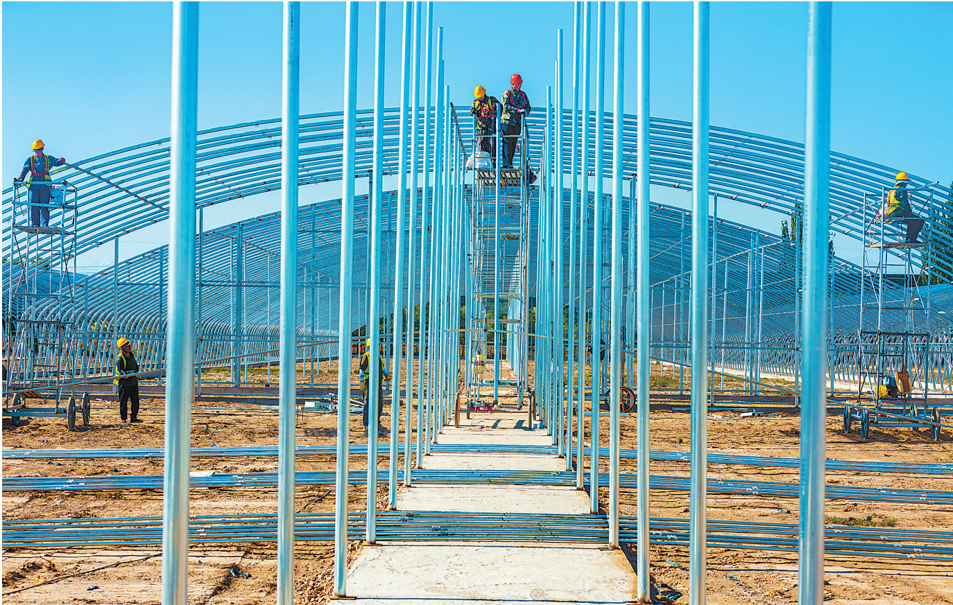
近日,工人在张掖市甘州区上秦镇进行标准化果蔬大棚安装作业。
