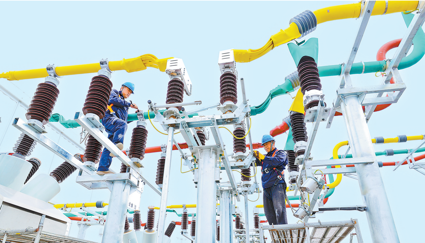
近日,在位于山丹县东乐镇的甘肃辉通独立储能电站建设现场,工作人员正在安装调试设备。 新甘肃·甘肃日报通讯员 王将
