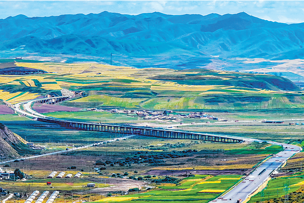
近日,乌海—玛沁高速公路合作至赛尔龙项目加紧施工。
