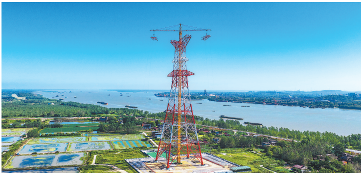
8月26日，在安徽芜湖，甘肃—浙江±800千伏特高压直流输电工程长江大跨越196米高的北岸输电塔顺利封顶。
