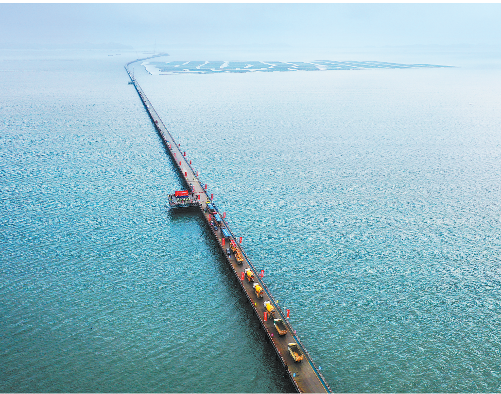
8月25日，大连海大桥梁项目建设取得关键进展，主线钢栈桥实现贯通。 新华社发
