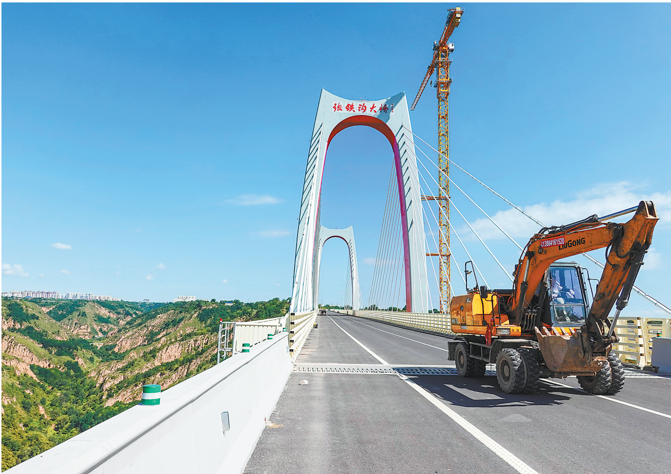
日前,G244庆阳东绕城线关键控制性工程——张铁沟特大桥施工进入收尾阶段。
