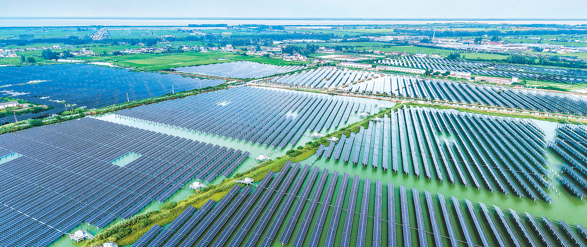
图为近日拍摄的位于江苏省扬州市邗江区公道镇的扬州洁源发电股份有限公司渔光互补发电项目。国网江苏省电力有限公司最新统计数据显示，截至2026年7月底，江苏省光伏发电累计装机容量突破1亿千瓦，达10008万千瓦，占全省电力总装机的比重超38%，超过煤电、气电和风电等，成为全省第一大电源。
