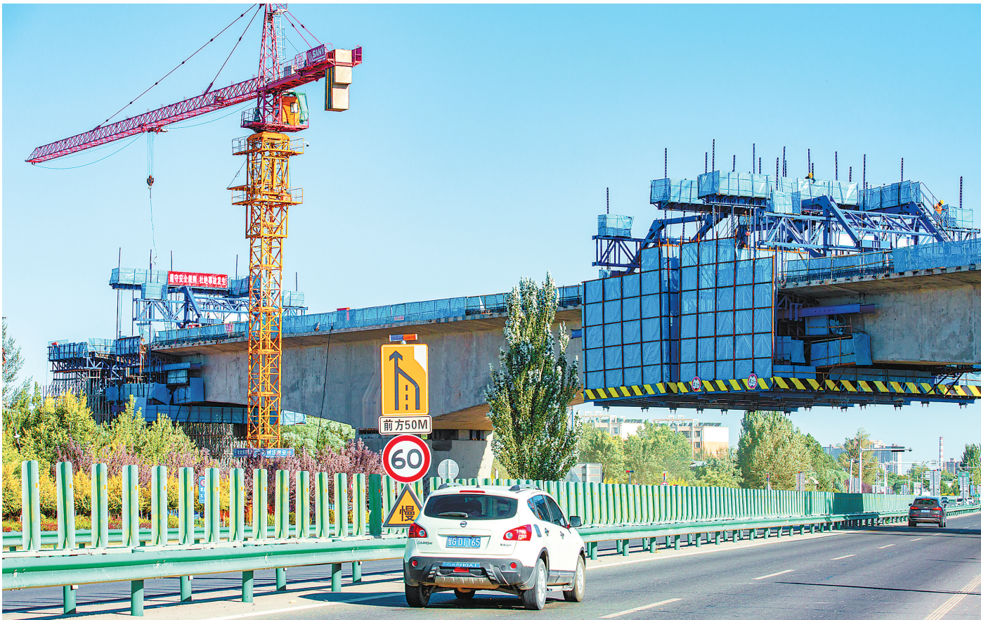
近日,兰张三四线铁路武威至张掖段建设现场,工人正在施工。
