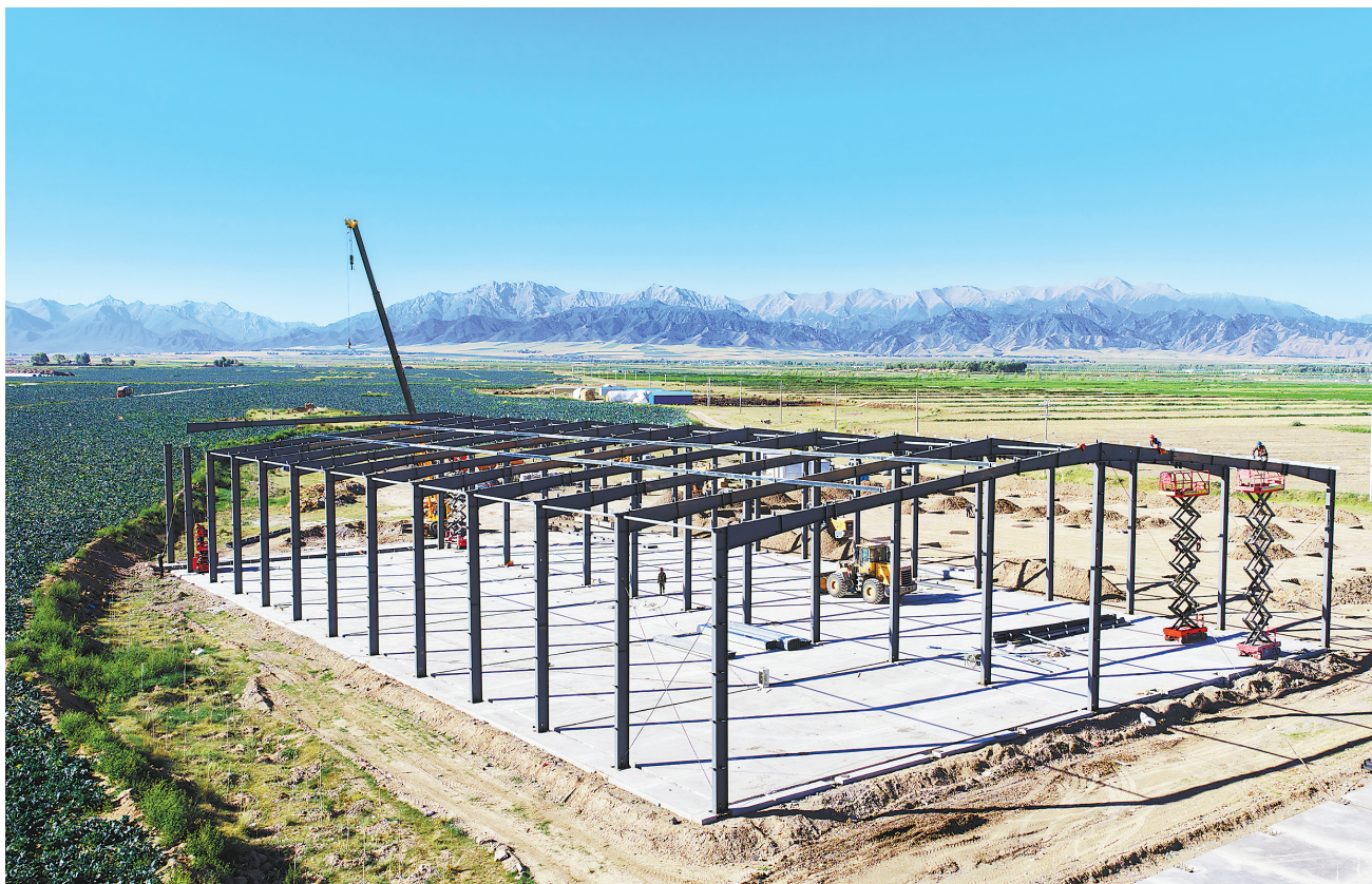
近日,在民乐县永固镇有机蔬菜产业园二期项目建设现场,工人正在加紧施工。 新甘肃·甘肃日报通讯员 王晓泾
