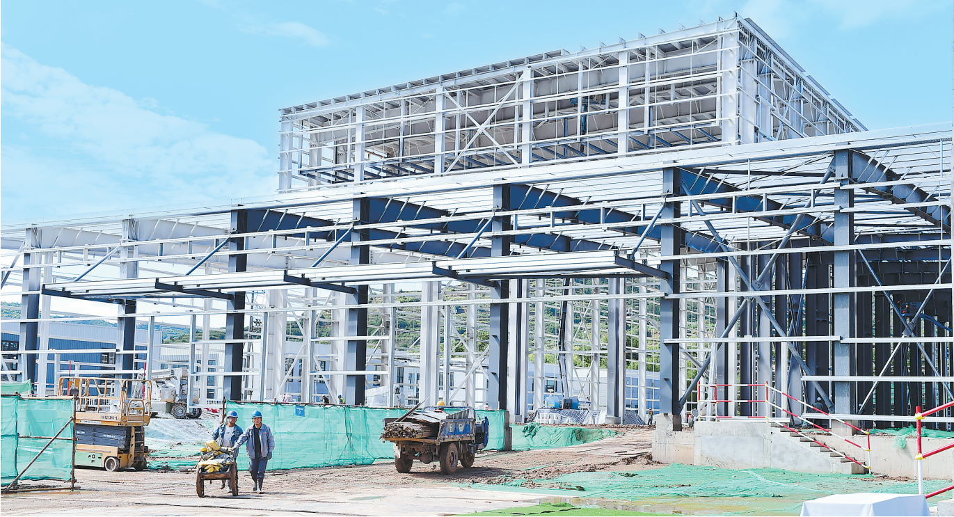
近日,镇原县圣农食品(甘肃)有限公司食品深加工项目建设现场,工人在加紧施工。
