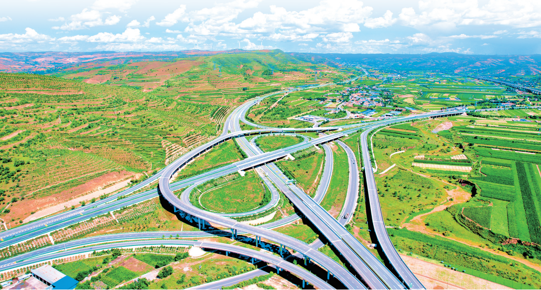
定西高速公路网。 金奉乾
