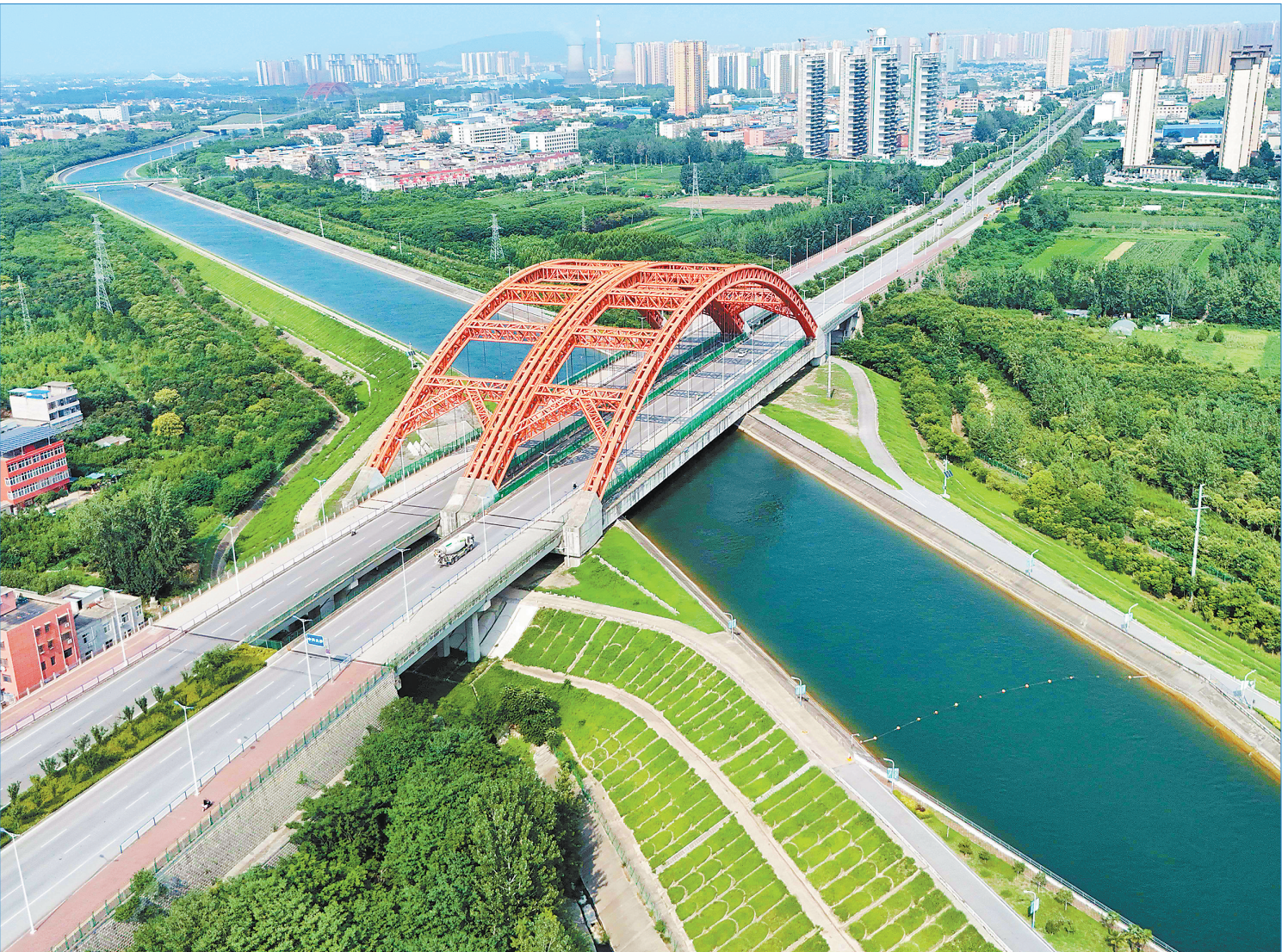
这是8月7日在河南省南阳市拍摄的南水北调中线工程干渠景色。据中国南水北调集团发布的数据,截至8月7日,南水北调中线工程累计向北方调水突破800亿立方米,惠及河南、河北、天津、北京近1.18亿人,为沿线27座大中城市243个县(市、区)经济社会发展提供有力的水资源支撑。 新华社发
