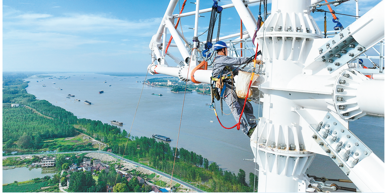
8月4日,安徽送变电工程有限公司施工人员在高空进行跨长江输电塔施工作业。盛夏时节,在位于安徽芜湖无为市高沟镇的“西电东送”重点工程——甘肃—浙江±800千伏特高压直流输电工程长江大跨越北岸输电塔建设现场,建设者们避开高温时段错峰作业,稳步推进重点工程建设。新华社发
