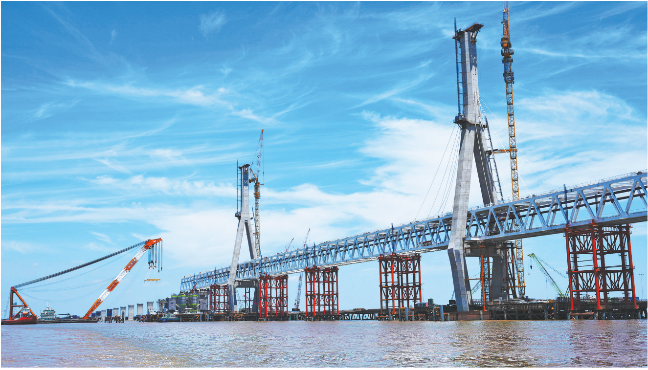
7月26日拍摄的杭州湾跨海铁路大桥南航道桥钢桁梁架设现场。杭州湾跨海铁路大桥是新建南通至宁波高速铁路关键控制性工程，全长29.2公里，采用时速350公里双线无砟轨道设计，由北、中、南三座航道桥及海中引桥、浅滩区引桥共同组成。 新华社发
