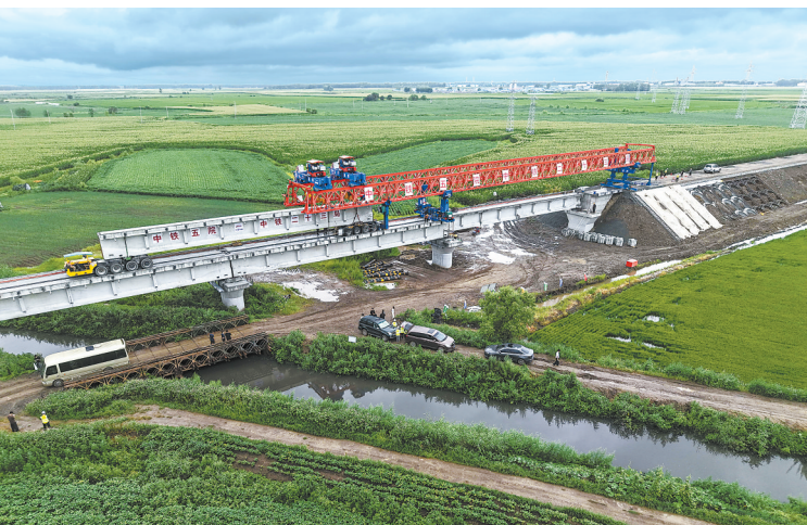
7月25日拍摄的黑龙江省佳木斯至同江铁路扩能改造工程同江特大桥架梁施工现场。当日，中欧班列“东通道”佳木斯至同江铁路扩能改造工程同江特大桥完成全部架梁任务。 新华社记者 王松
