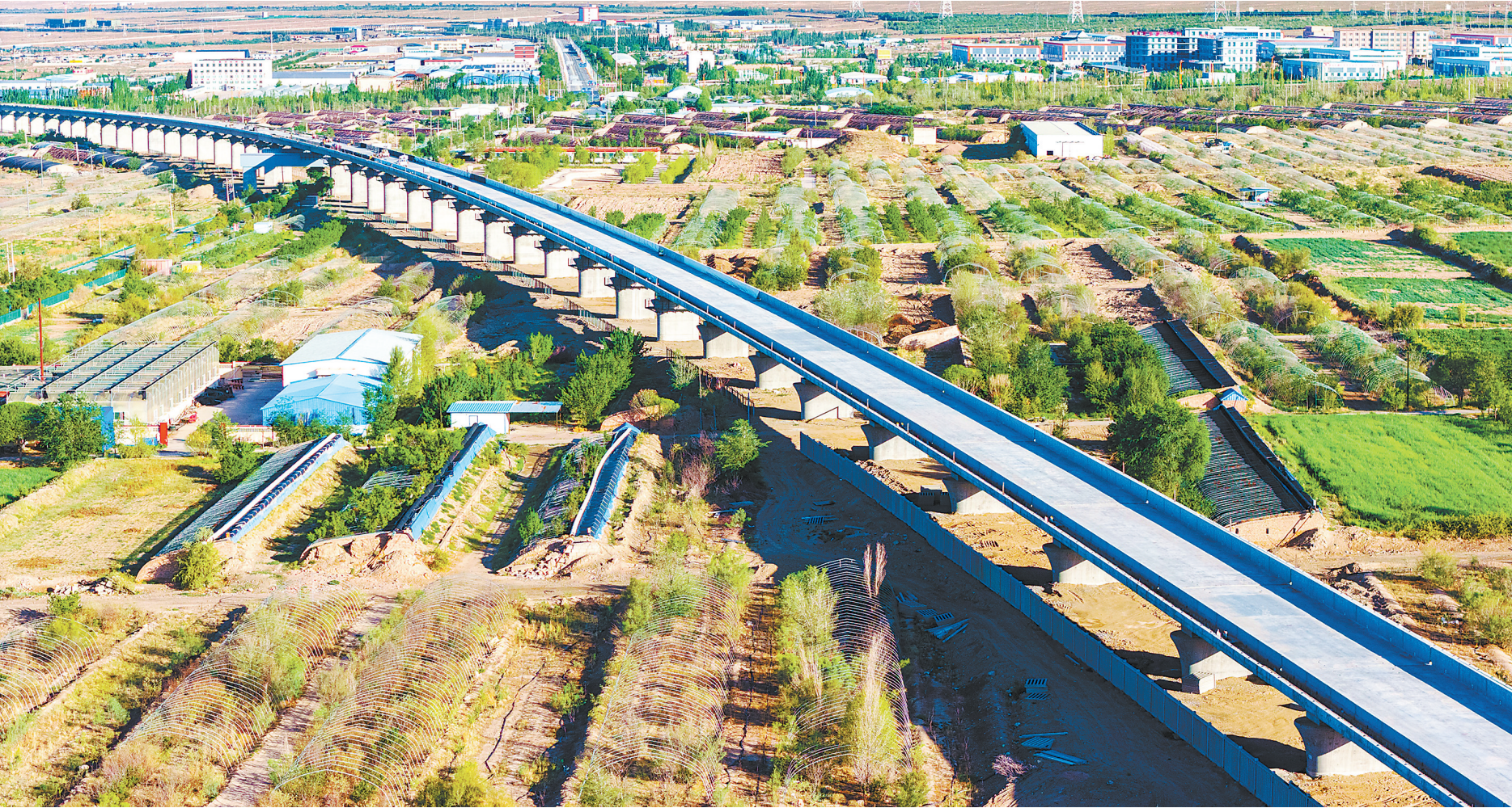
近日,兰张三四线铁路武威至张掖段山丹特大桥顺利合龙。 新甘肃·甘肃日报通讯员 杨永伟
