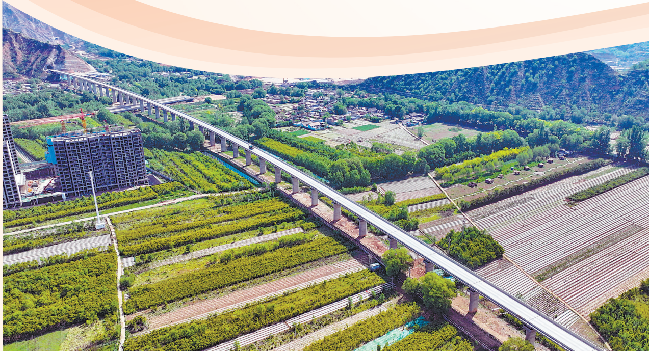
兰合铁路临夏段正在建设中。
