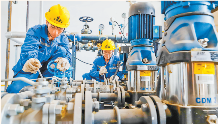
位于张掖经济技术开发区生态科技产业园的甘肃纳塔新材料项目建设现场。
