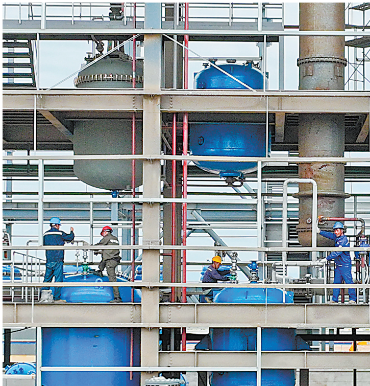
近日，高台县盐池工业园项目建设现场，工人在安装设备。
