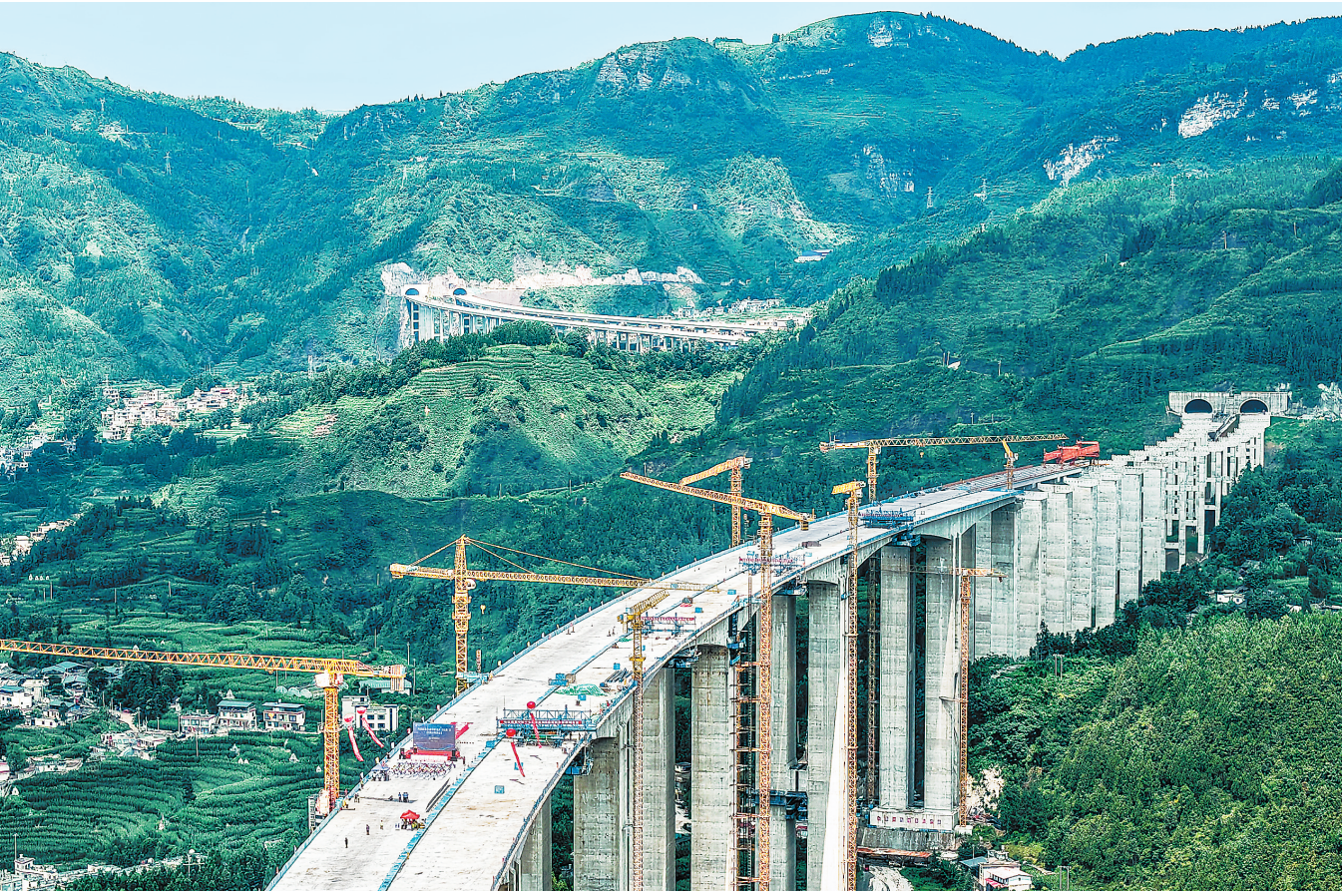
7月16日,由中铁十七局承建的贵州安(顺)盘(州)高速控制性工程——盘关特大桥主桥顺利合龙,标志着项目建设取得突破性进展,为全线按期建成通车奠定了坚实基础。
