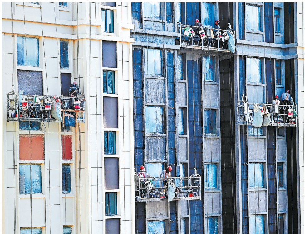
△在张掖市甘州区华府天地小区施工现场,建筑工人进行外墙改造。 新甘肃·甘肃日报通讯员 张渊 ◁兰州市公安局交管大队城关大队交警疏导车流。 新甘肃·甘肃日报记者 裴强
