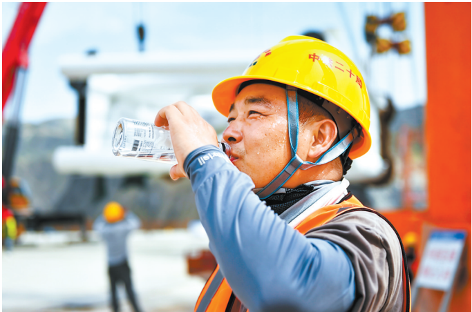
兰永临高速公路永靖段洮河特大桥施工现场,施工人員喝水降温。 新甘肃·甘肃日报记者 马伊星
