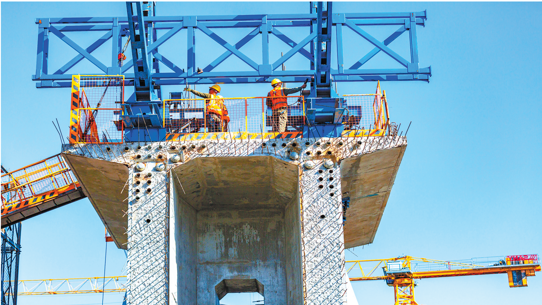
兰张三四线铁路武威至张掖段建设现场,工人正在作业。 新甘肃·甘肃日报通讯员 杨永伟
