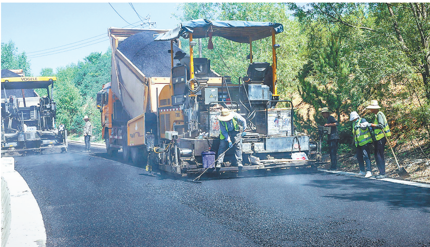
施工人员在通渭县农村公路提升改造工程现场进行路面铺设作业。 新甘肃·甘肃日报通讯员 张子斌
