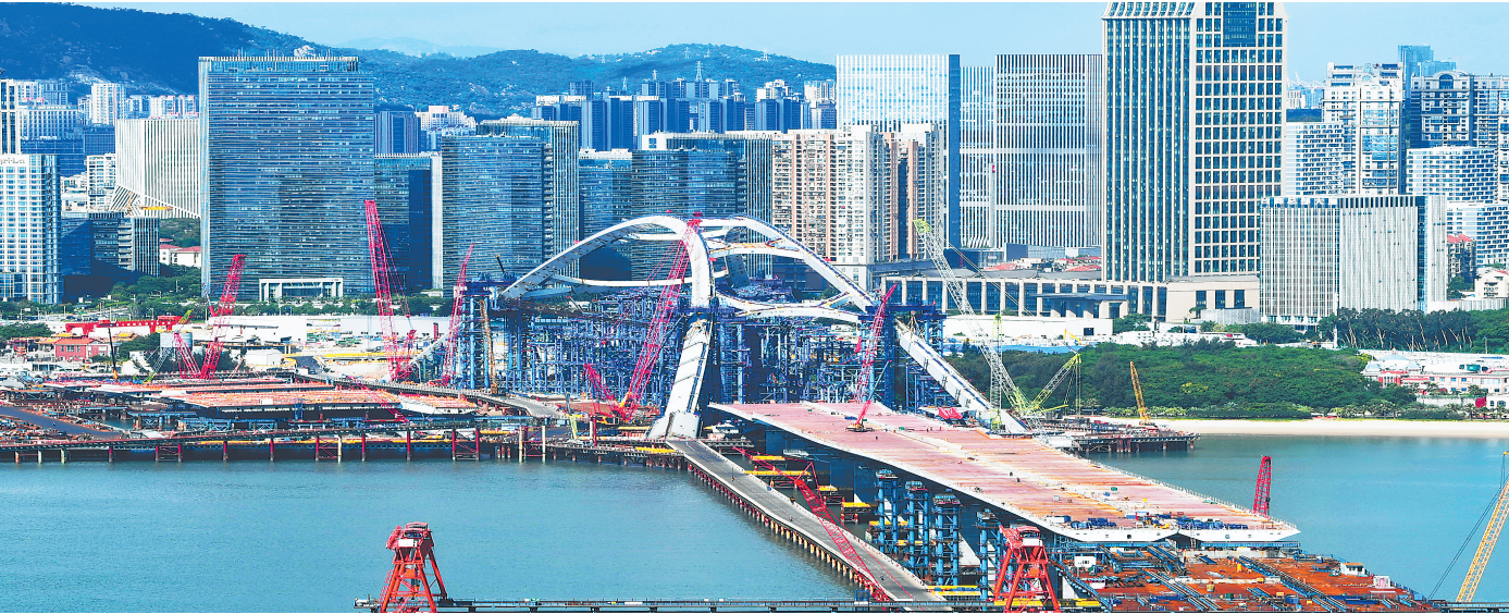
7月8日,厦金大桥(厦门段)项目观音山互通主线桥拱肋对接合龙。
