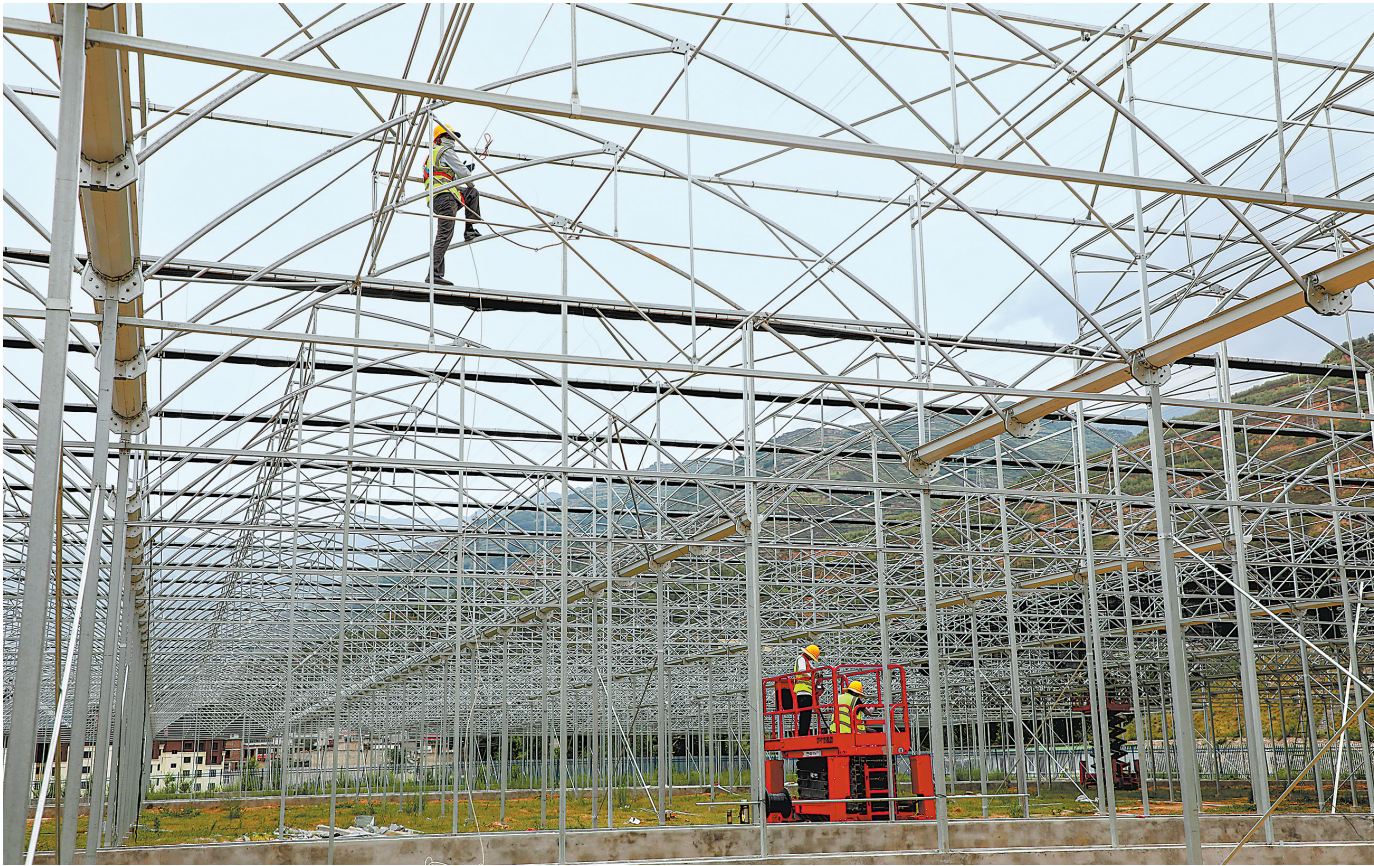
近日,宕昌县沙湾镇现代农业产业园区建设现场,工人组装高效节能智慧钢构架大棚。
