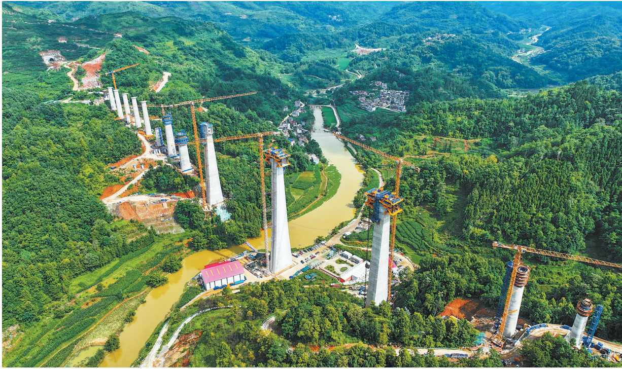
7月2日拍摄的六志河特大桥全景。六志河特大桥位于贵州省安顺市镇宁县城寨镇，是黄百铁路贵州段的重难点工程。黄百铁路全长约315公里，设计时速160公里，为国家Ⅰ级单线电气化铁路，预计2028年建成通车。
