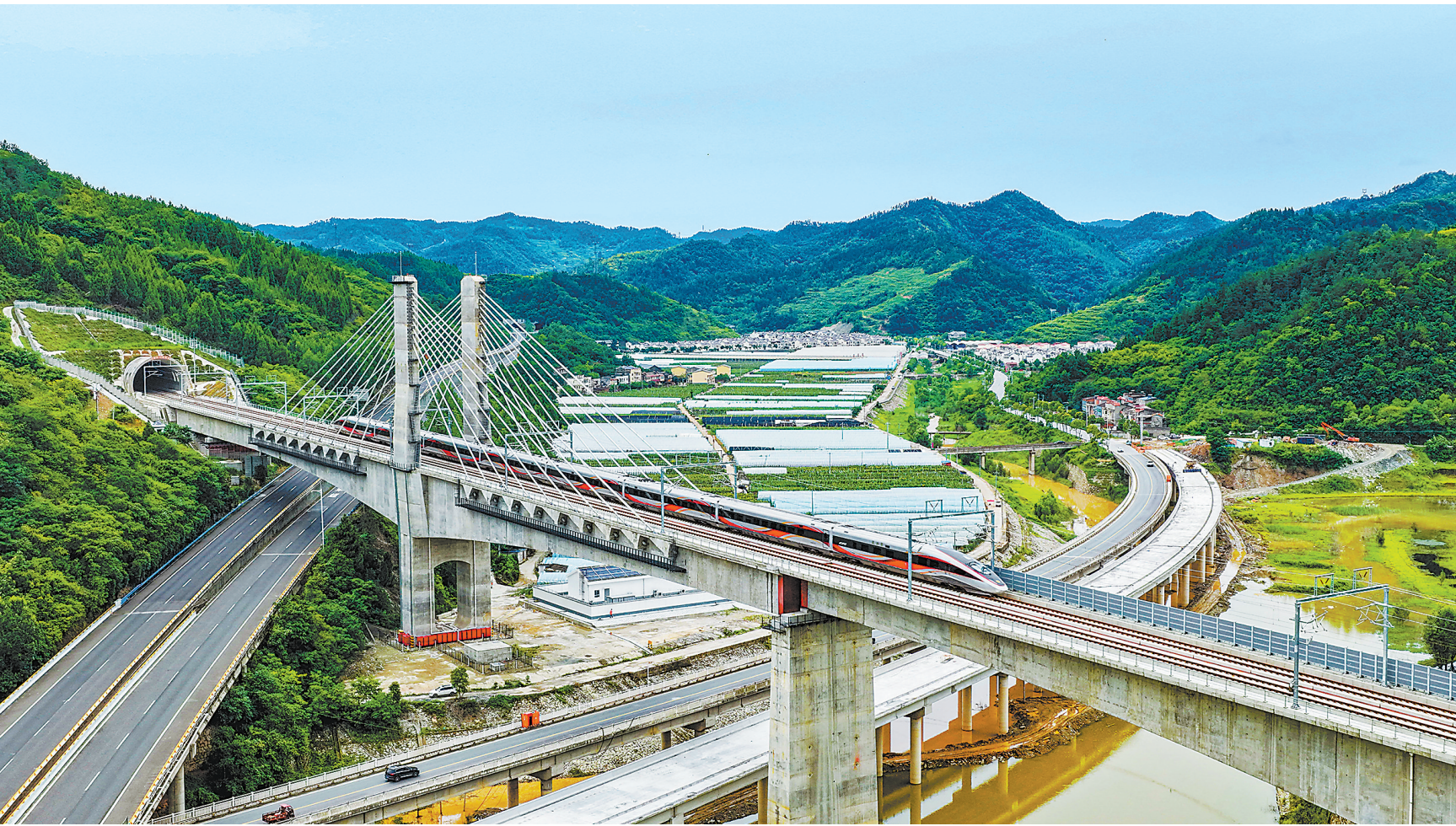
6月30日，列车驶过位于湖北十堰的西十高铁柳家河福银立交大桥。6月30日上午9时16分，G3966、G3969次列车分别从西安东站和十堰东站对向开出，西安至十堰高速铁路正式开通运营。
