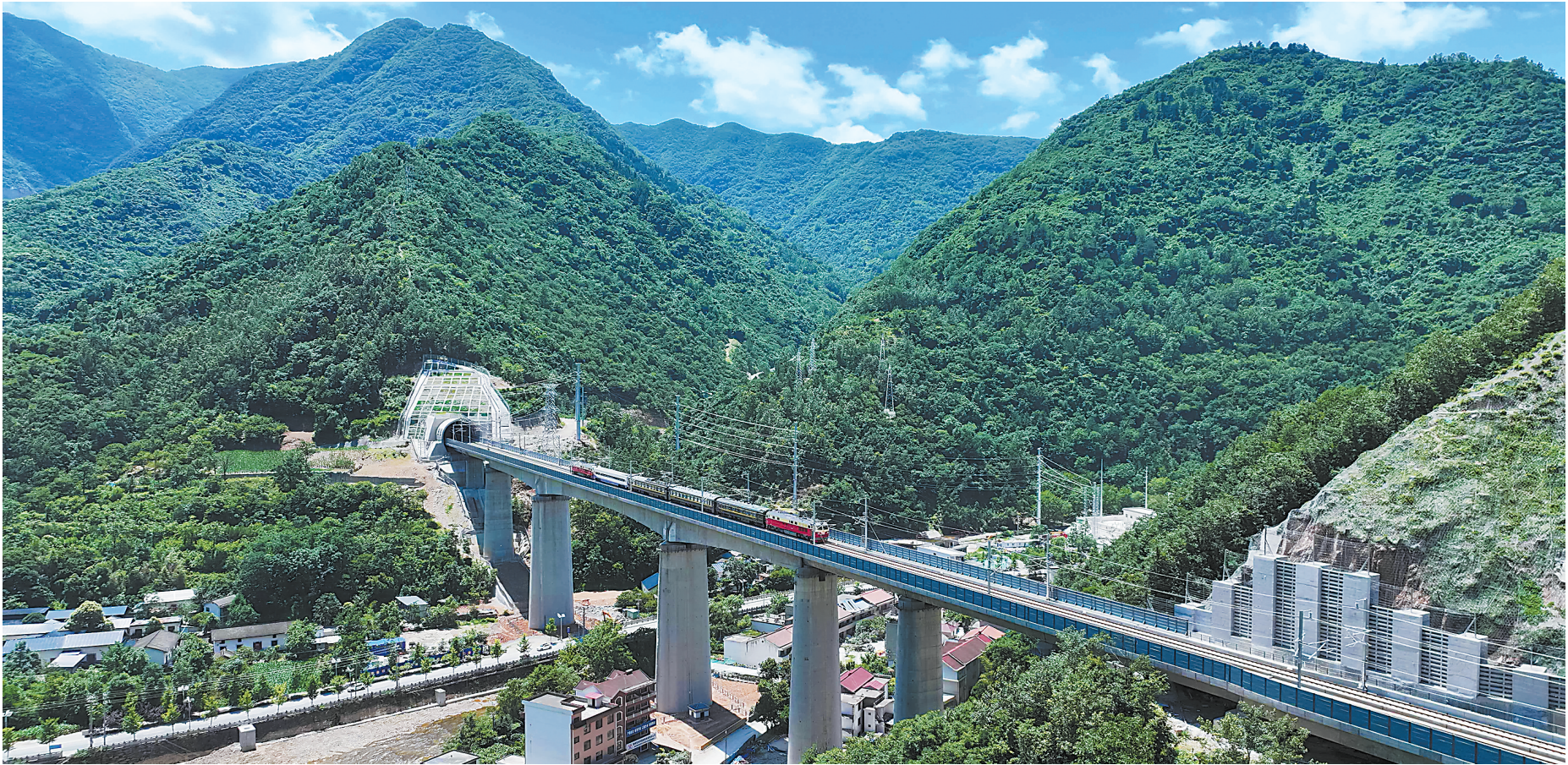
6月27日上午，随着57611次专业检测列车从西安东站缓缓驶出，一路穿越秦岭山脉向安康西站方向，标志着西康高铁全线进入联调联试阶段。西安至安康高速铁路是国家中长期铁路网规划“八纵八横”高铁通道中包（银）海通道、京昆通道的重要组成部分，新建正线全长约171公里，设计时速350公里，建成通车后，西安至安康的铁路运行时间将由目前的3小时左右缩短至1小时以内。
