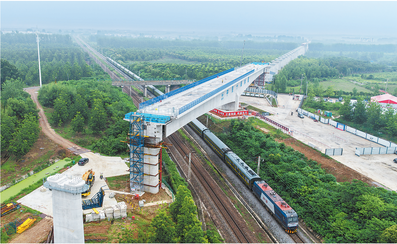
6月25日,在安徽省合肥市肥西县境内,由皖赣铁路安徽公司建设管理、中铁十局承建的合武高铁庐安特大桥跨宁西铁路200米T构连续梁成功完成35度“空中转体”。该梁总重1.5万吨,此次成功转体标志着全线架梁通道建设取得阶段性进展,为后续无砟轨道施工奠定了坚实基础。图为当日拍摄的转体后的合武高铁庐安特大桥跨宁西铁路万吨连续梁。
