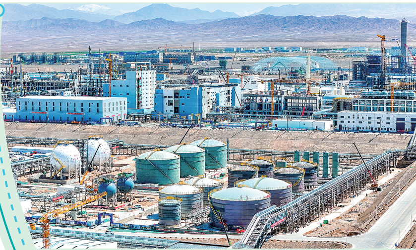
位于玉门市老市区化工园区的甘肃巨化高性能硅氟新材料一体化项目建设现场。玉门市融媒体中心供图
