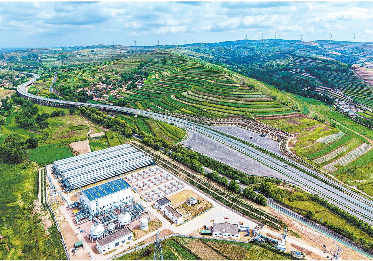
近日,在通渭县马营镇,新型储能电站与风电场、现代设施农业区构建起“风光储+农业”多元产业格局。
