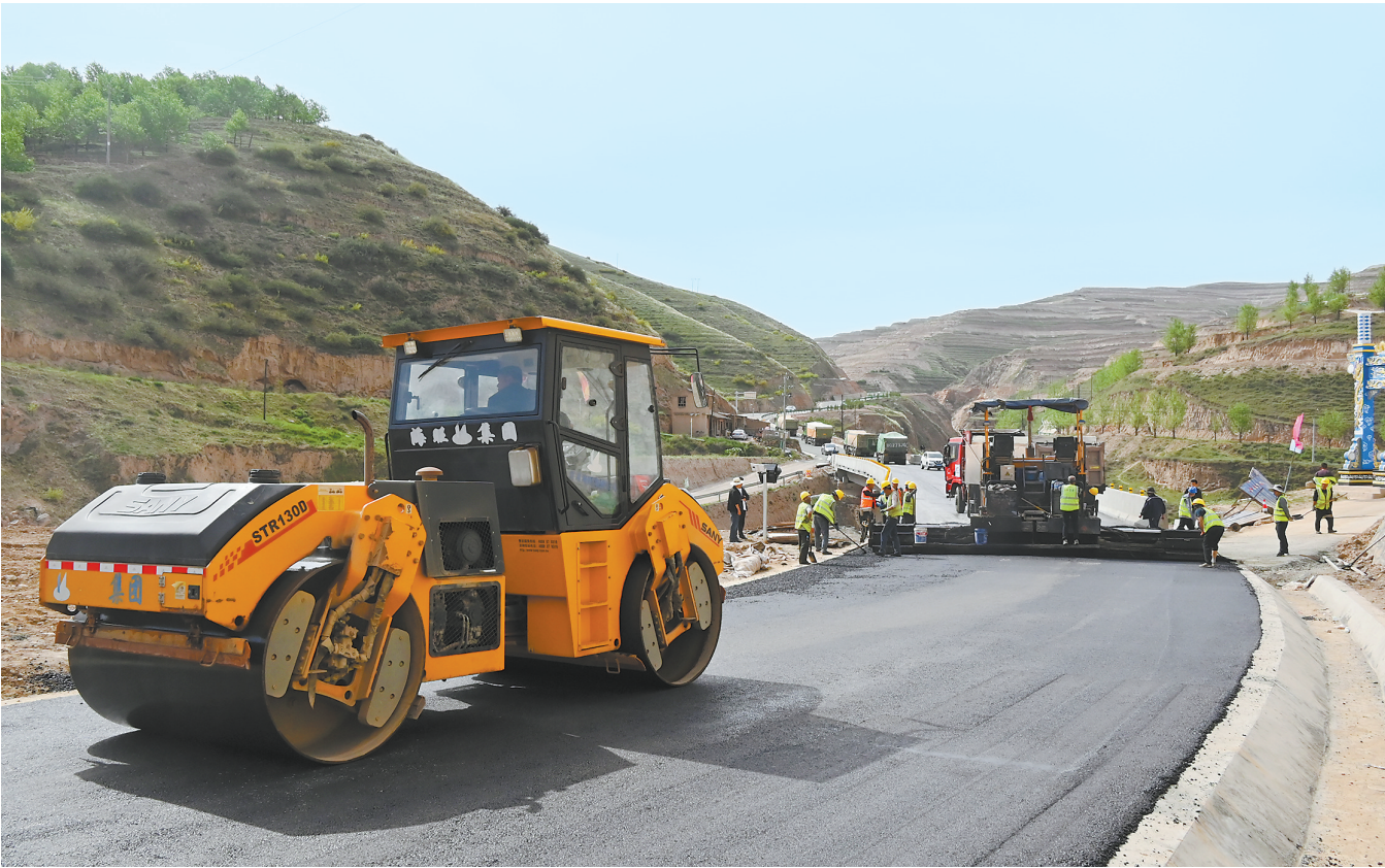
近日，省道S229线临洮段升级改造施工现场，施工人员进行加紧作业。
