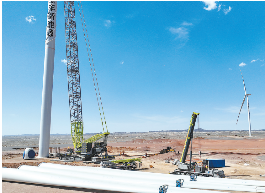
近日,金塔县锦昊风能开发有限公司100万千瓦风力发电项目开展风力发电机组主机安装作业。 新甘肃·甘肃日报通讯员 曹红祖
