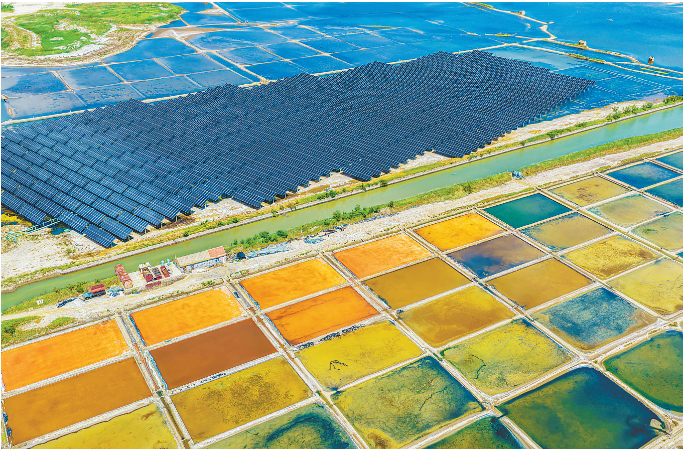
日前在山东省荣成市北部沿海拍摄的盐田与水上光伏阵列。近年来，山东省因地制宜探索实施农光、渔光、盐光、油光等“光伏+”互补模式，不仅提升了清洁能源供给能力，也通过“一地两用、一业多收”，增加了村集体收入和农民收益，走出了一条清洁能源、生态环境与经济效益“三赢”的绿色发展之路。
