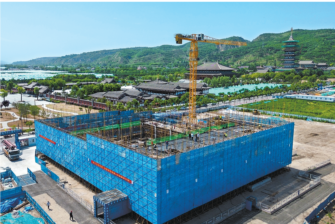
初夏时节,泾川县全民健身中心项目施工正在有序推进。
