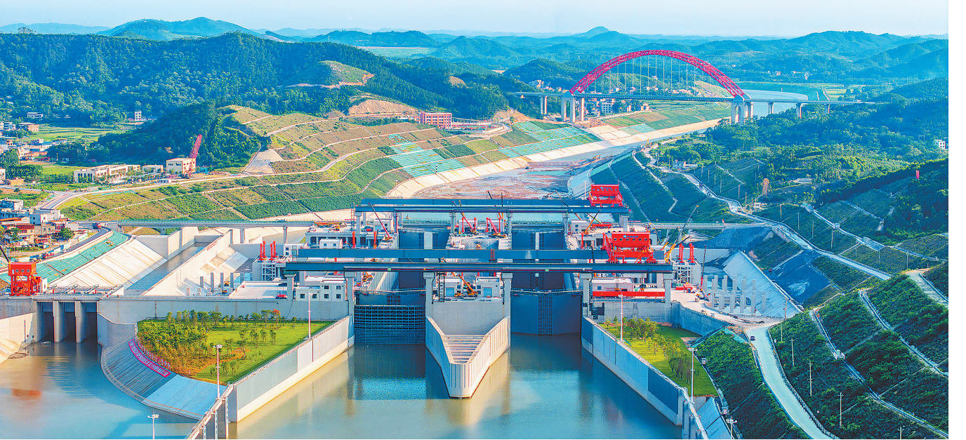
6月3日，随着平陆运河马道枢纽和企石枢纽正式开始充水，平陆运河全线通水，全面进入有水调试阶段。这是当日拍摄的广西平陆运河马道枢纽充水现场。
