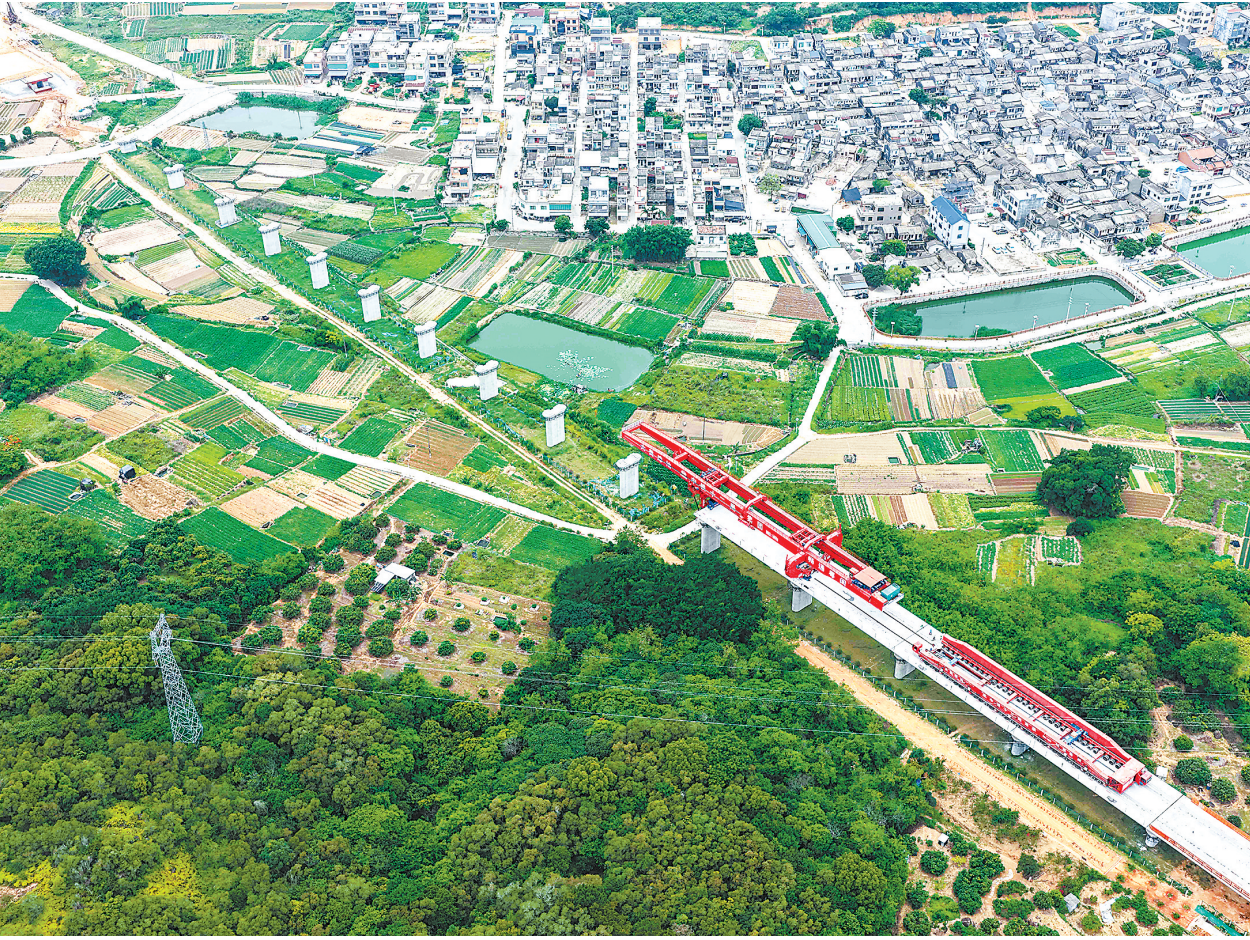
5月31日拍摄的广东漳州高铁山家特大桥架桥机架梁现场。漳州至汕头高速铁路建成通车后，将与福厦高铁、广汕高铁等共同组成沿海大通道，进一步完善区域路网结构，助力国家东部沿海地区高质量发展。
