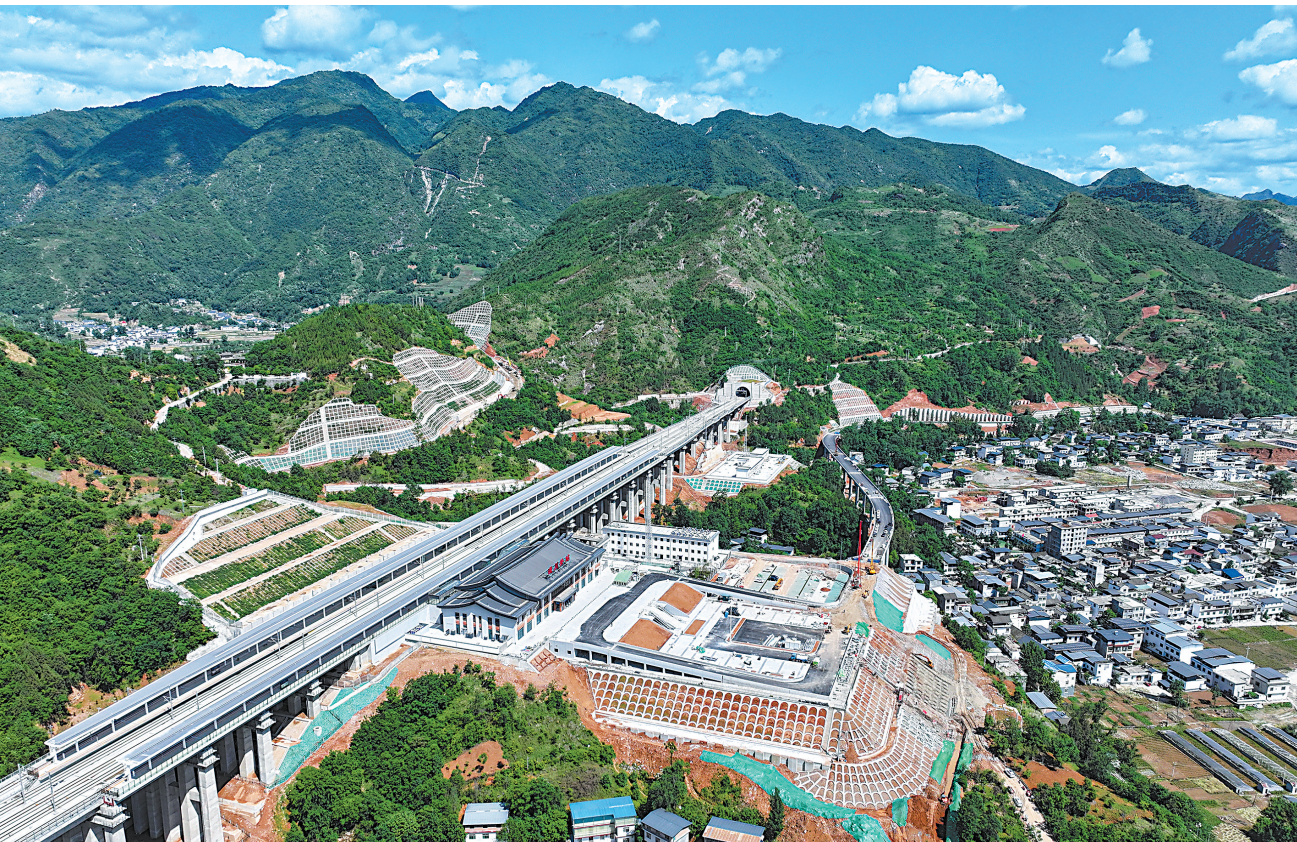
这是5月20日拍摄的西(安)十(堰)高铁渭川站。目前西十高铁完成全线拉通试验,联调联试各项试验有序开展,沿线蓝田、商洛西、山阳、渭川关等新建车站站房装修已基本完成,部分车站站前广场配套工程正加紧收尾推进。新华社发
