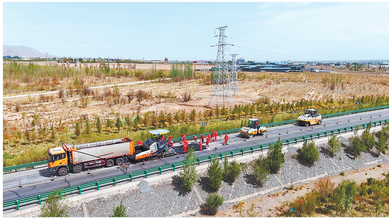
近日,在G312线山丹县邮庄至长城新村路段,公路养护人员开展夏季油路修补工作。新甘肃·甘肃日报通讯员 陆波
