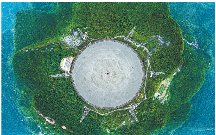
5月6日拍摄的“中国天眼”全景。近日,被誉为“中国天眼”的500米口径球面射电望远镜启动馈源驱动钢丝绳更换工作。此前该部件依赖进口,2023年1月研发团队自主研发,于2025年8月成功实现国产化。目前6根国产钢丝绳已运抵现场,更换工作预计持续至6月下旬。
