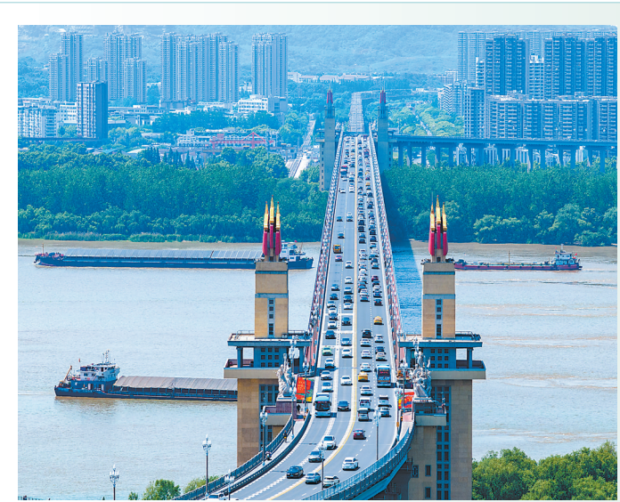
这是“五一”假期的南京长江大桥。来自交通运输部的数据显示,“五一”假期全社会跨区域人员流动总量为151712.8万人次,日均为30342.56万人次,同比增长3.49%。
